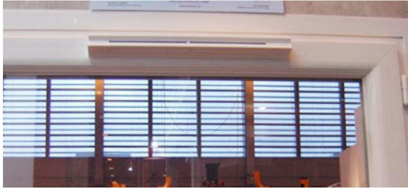
Figura 3: esempio di possibile installazione ad infisso di un dispositivo di ingresso dell'aria per sistemi a semplice estrazione.
