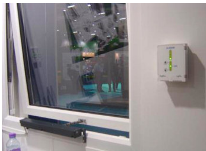
Figura 1: dispositivo di apertura automatica di un serramento sulla base degli input forniti da un sensore di CO 2 installato a fianco della finestra stessa.
